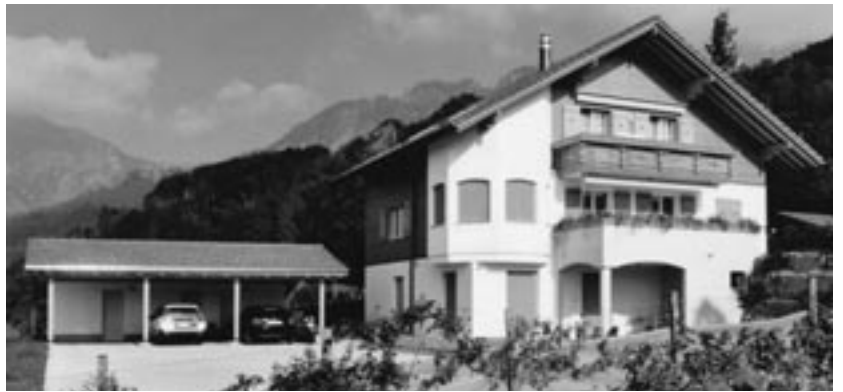
Nouvelle construction du bâtiment d'habitation à Kerns OW
