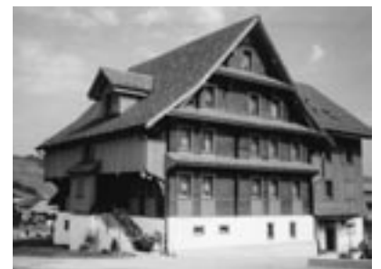
Assainissement de la maison d'habitation, Rothenthurm SZ
