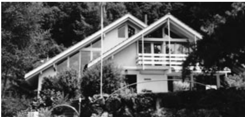
Maison d'habitation avec construction attenante à Greppen LU
