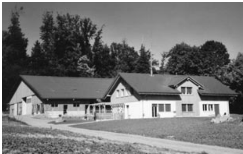
Nouvelle construction d'un lotissement à Herrliberg ZH
